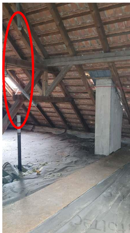
ZT-34 – Objekt D (chybějící propojení)
