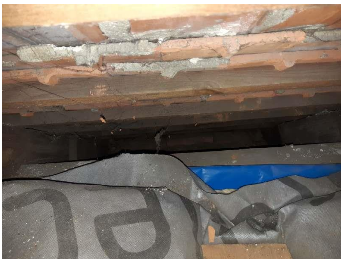
Chybějící tepelná izolace šikmině – Objekt A
