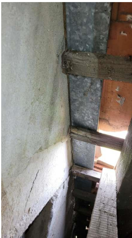
DEF-10 – Objekt B (chybějící střešní taška)
