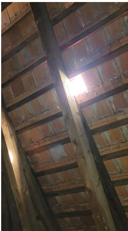
DEF-03 – Objekt A (chybějící střešní taška)
