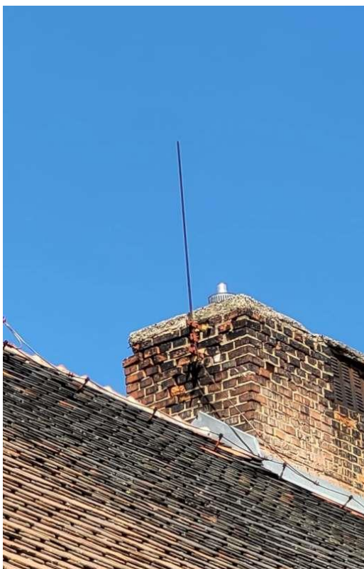
Hromosvod – jímací tyč upevněna na komínovém tělese
