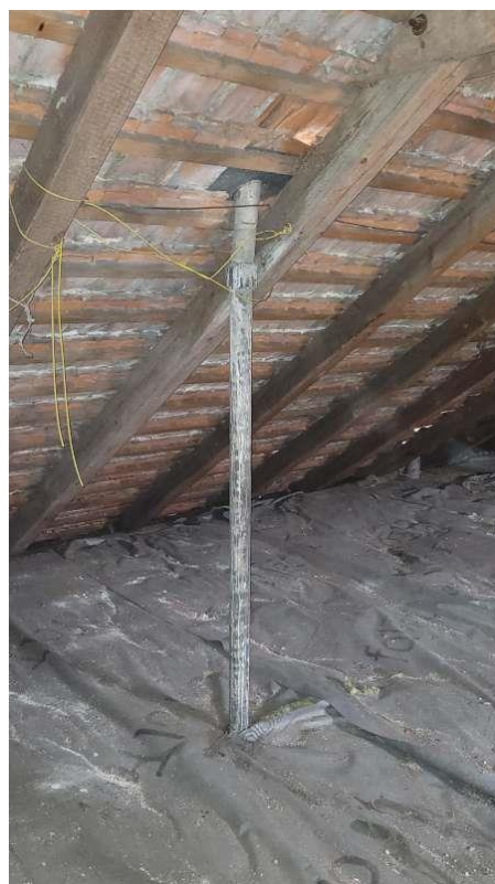
ZT-26 – Objekt C (průběžná trubka nad střechu)
