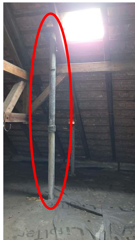
ZT-32 – Objekt D (průběžná trubka nad střechu)
