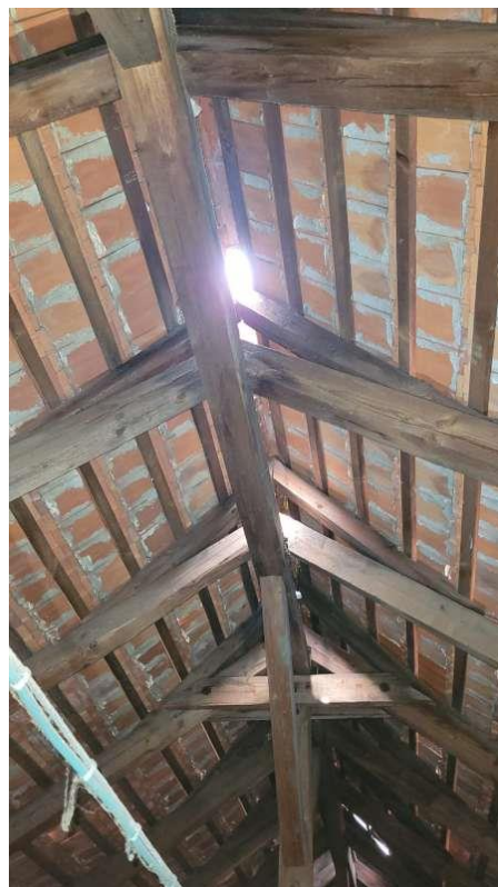
DEF-06 – Objekt A (chybějící hřebenáče)
