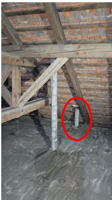
ZT-09 – Objekt A (průběžná trubka nad střechu)
