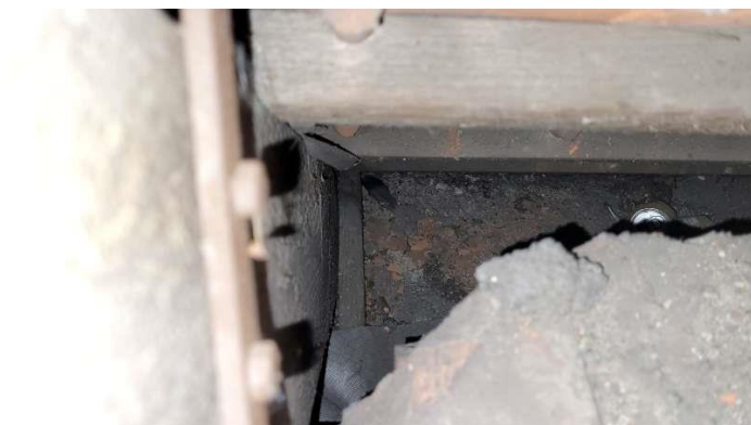
Chybějící tepelná izolace v šikmině – Objekt D
