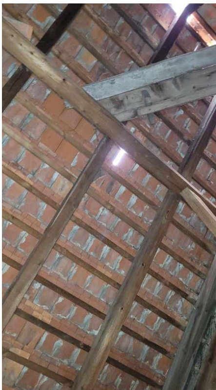
DEF-15 – Objekt D (chybějící střešní taška)
