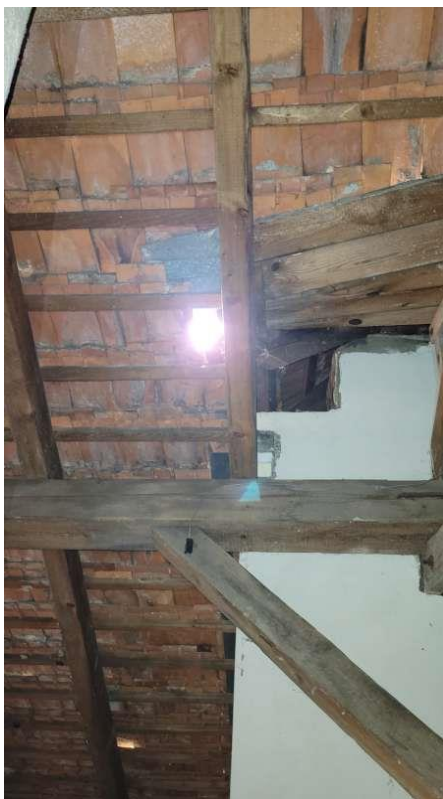
DEF-11 – Objekt C (chybějící střešní taška)
