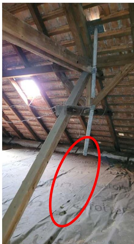
ZT-14 – Objekt B (chybějící propojení)
