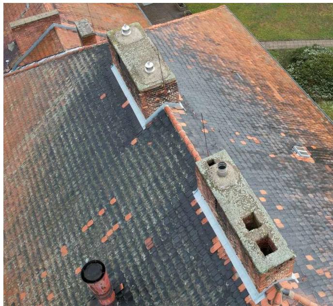
Klempířské prvky – oplechování kom. těles budova C (Zdroj: foto z dronu PKV BUILD, s.r.o.)
