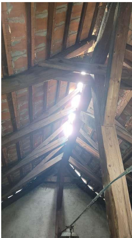
DEF-07 – Objekt A (chybějící hřebenáče)
