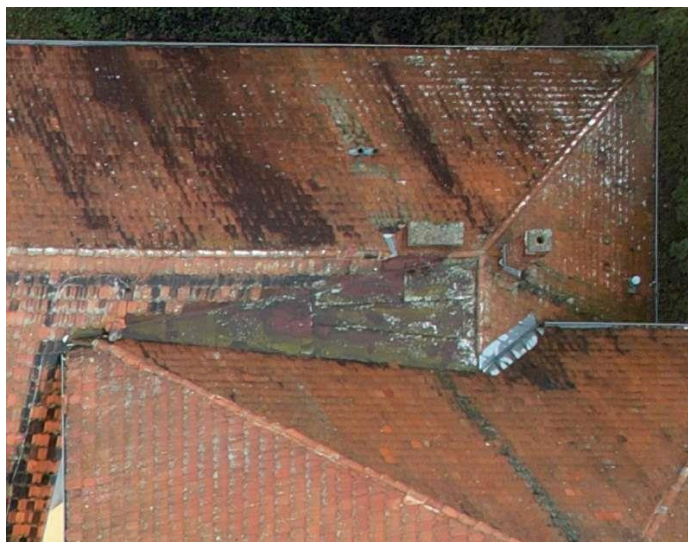
Klempířské prvky – napojení střech budov C-D (Zdroj: foto z dronu PKV BUILD, s.r.o.)
