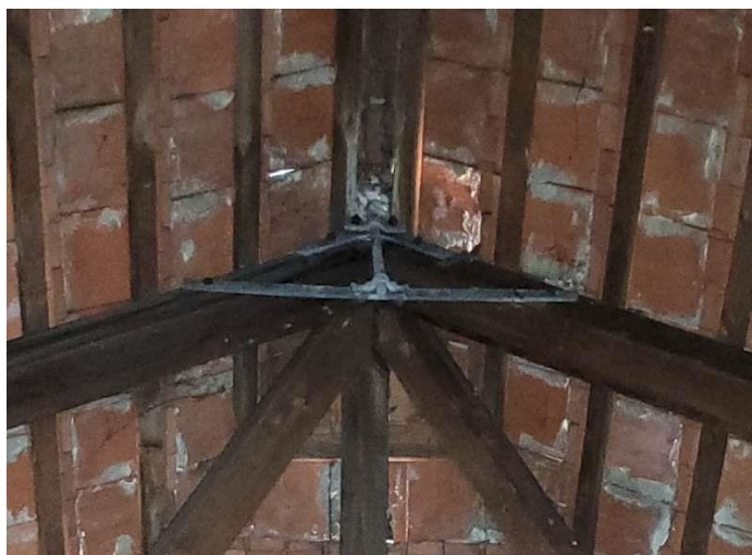
Hromosvod – jímací tyč na krokvi
