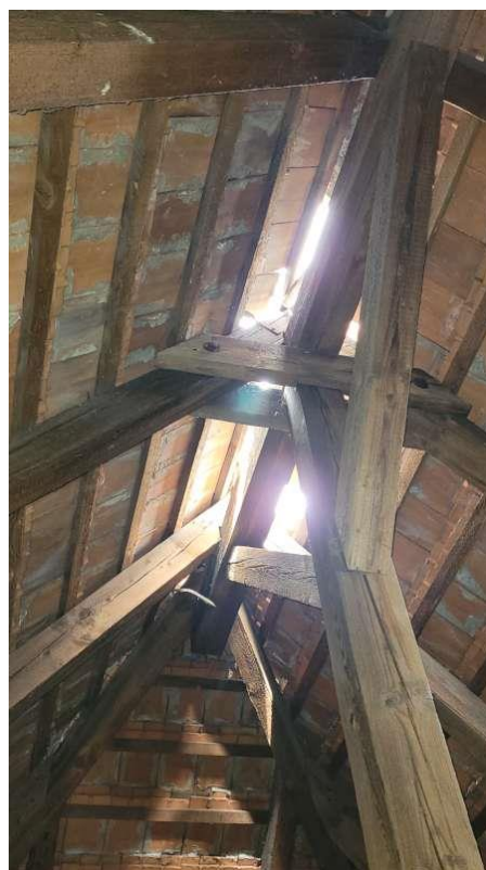
DEF-02 – Objekt A (chybějící hřebenáče)
