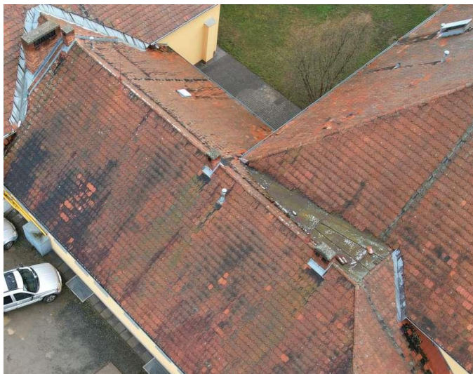
Klempířské prvky – nároží budov B–C (Zdroj: foto z dronu PKV BUILD, s.r.o.)
