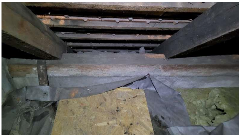
Porušené spoje difuzní fólie
