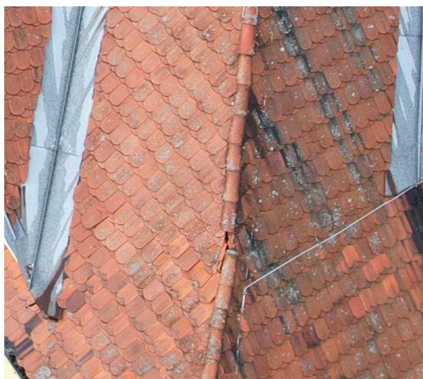
DEF-01 – Objekt A (chybějící hřebenáče)
