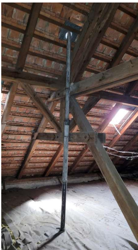
ZT-15 – Objekt B (průběžná trubka nad střechu)
