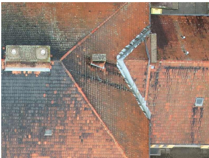
Klempířské prvky – napojení střech budov C (Zdroj: foto z dronu PKV BUILD, s.r.o.)
