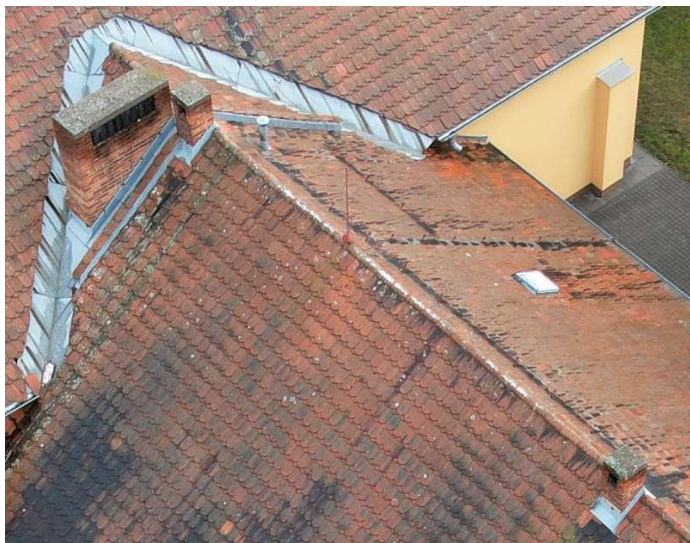
Klempířské prvky – napojení střech budov C (Zdroj: foto z dronu PKV BUILD, s.r.o.)
