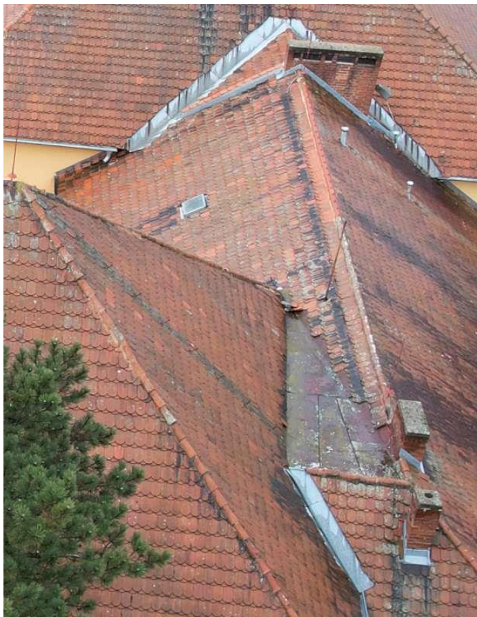
Klempířské prvky – napojení střech budov C-D (Zdroj: foto z dronu PKV BUILD, s.r.o.)
