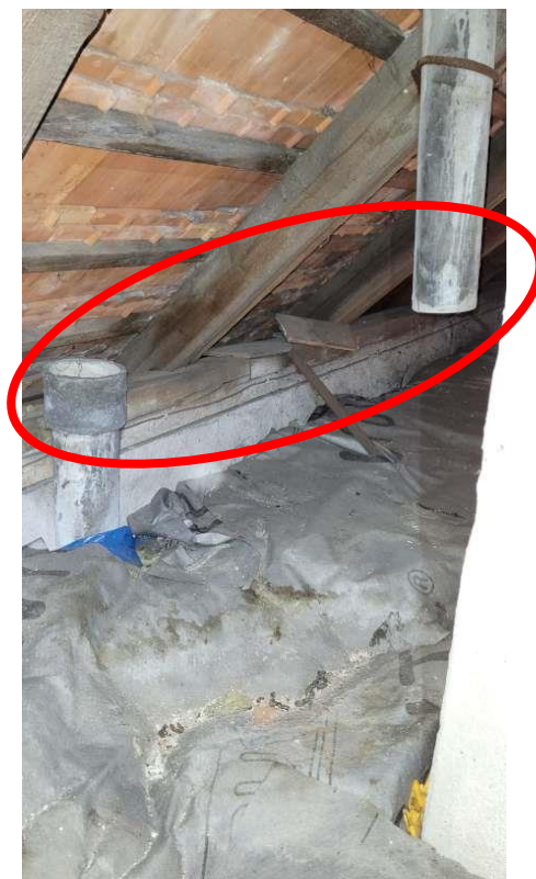
ZT-16 – Objekt B (chybějící propojení)
