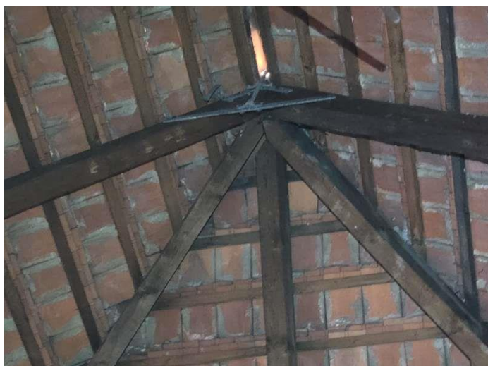
Hromosvod – jímací tyč na krokvi
