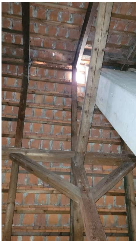
DEF-13 – Objekt D (chybějící střešní taška)
