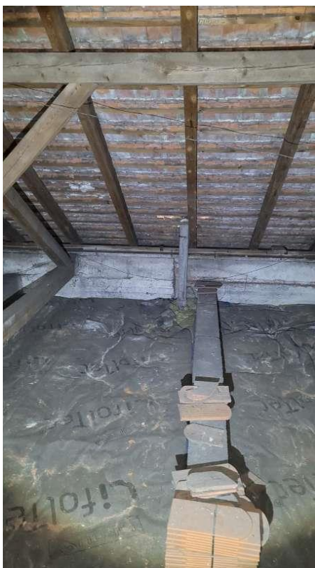
ZT-23 – Objekt C (průběžná trubka nad střechu)
