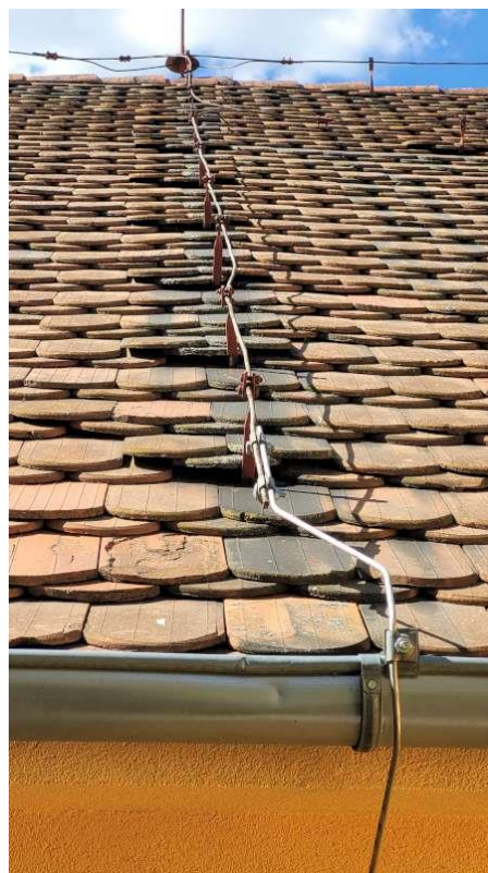
Hromosvod – spoj zemního drátu, nový se stávajícím
