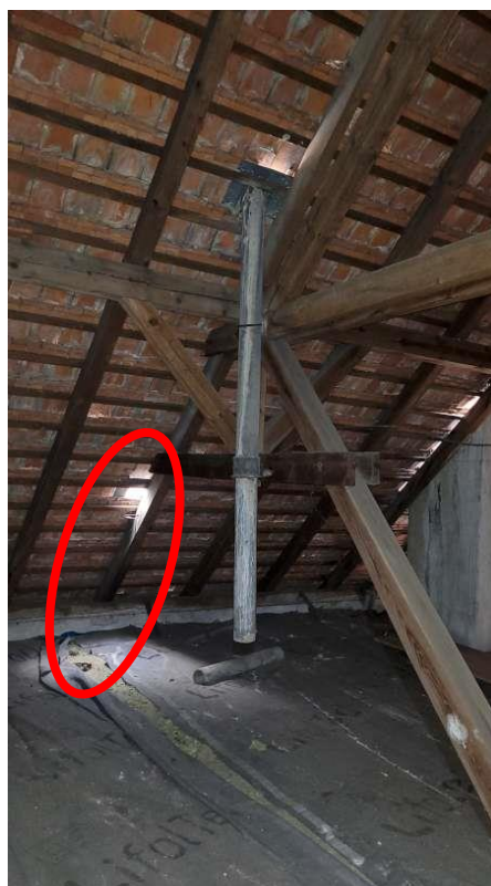
ZT-18 – Objekt B (chybějící propojení)
