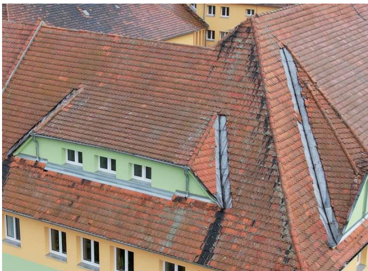
Klempířské prvky – nároží budov A–B (Zdroj: foto z dronu PKV BUILD, s.r.o.)
