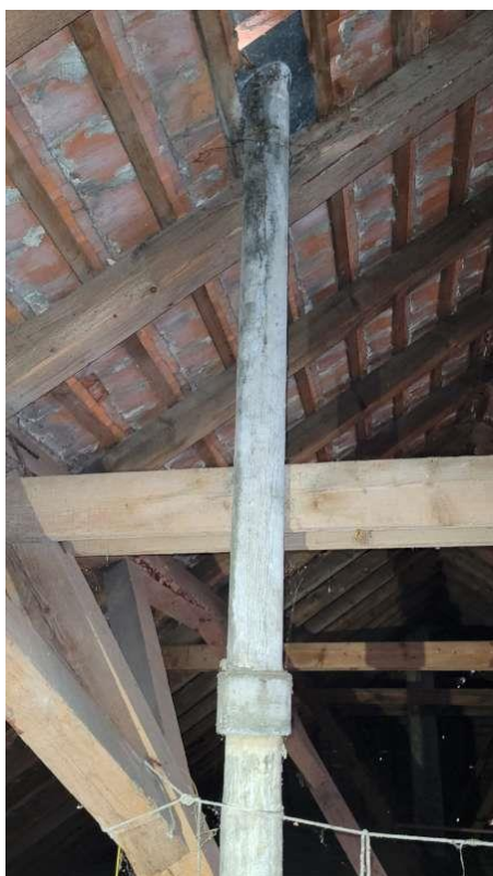
ZT-25 – Objekt C (průběžná trubka nad střechu)
