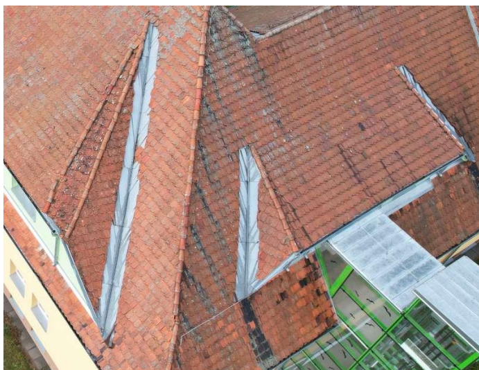
Klempířské prvky – nároží budov A–D (Zdroj: foto z dronu PKV BUILD, s.r.o.)
