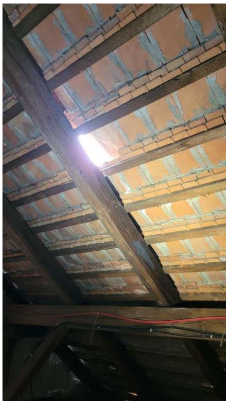
DEF-05 – Objekt A (chybějící střešní taška)
