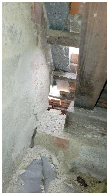
DEF-16 – Objekt D (chybějící střešní taška)
