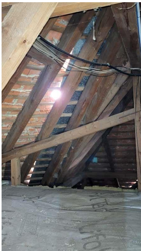
DEF-09 – Objekt A (chybějící střešní taška u oplechování)
