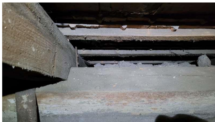
Chybějící tepelná izolace u atiky a v šikmině – Objekt D
