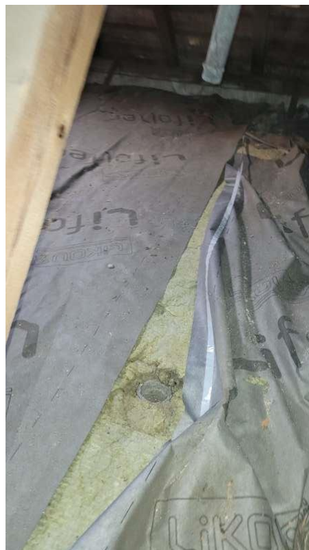
Porušené spoje difuzní fólie
