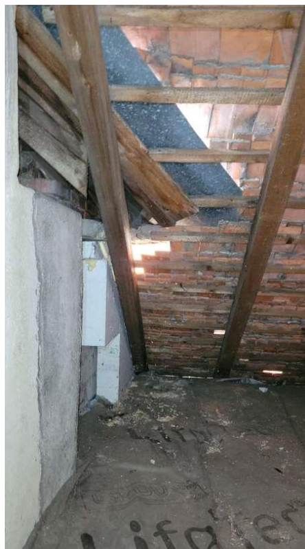
DEF-12 – Objekt C (chybějící střešní taška)
