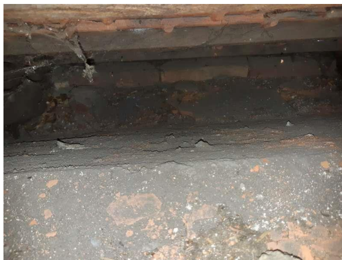
Chybějící tepelná izolace šikmině detail – Objekt A
